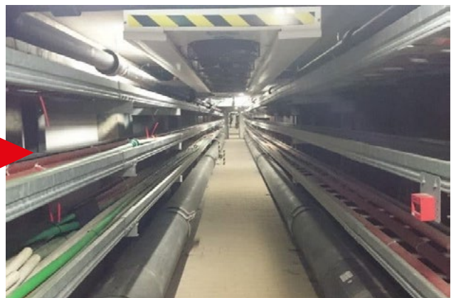
Situatie met gebruik van kabeltunnel, Bron: IJtunnel
