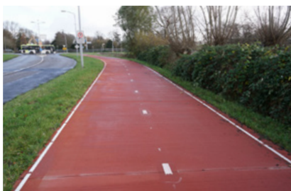
Gerealiseerd fietspad met gekoppelde betonplaten, Venneweg Hoorn
