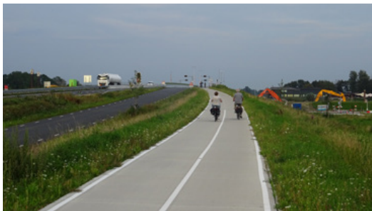
HWFR Hanzepad: viaduct
