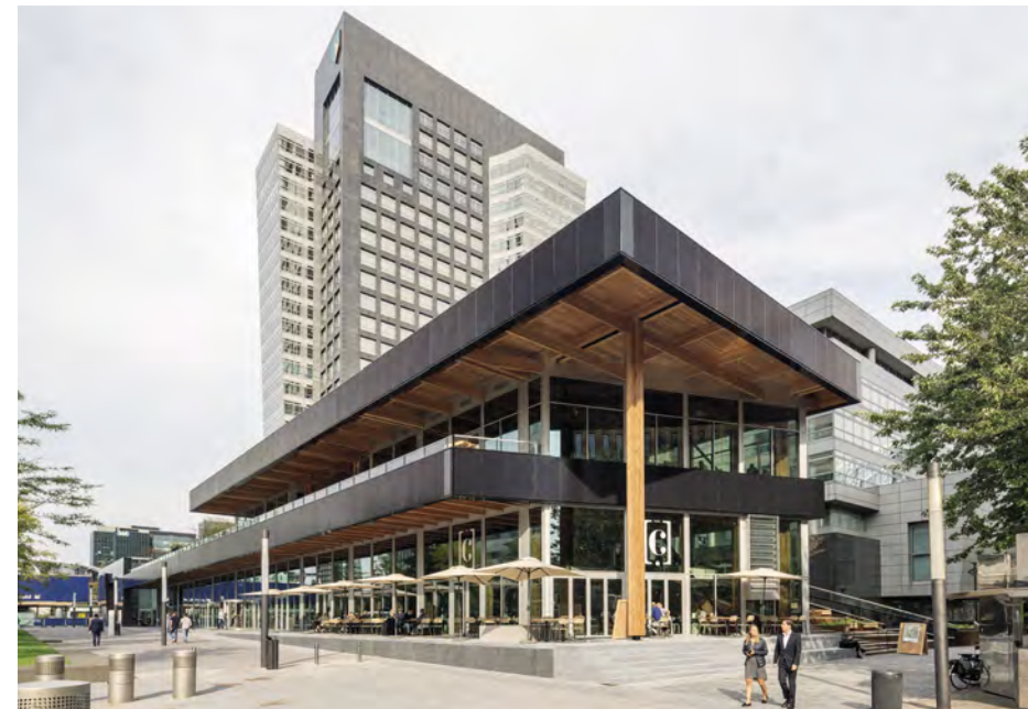
In het Circl paviljoen in Amsterdam (Architecten Cie.) zijn de glulam-balken demontabel en overgedimensioneerd, waardoor bij einde levensduur de balken met commerciële maten vrijkomen. De leverancier (Derix) heeft aangegeven de balken terug te willen nemen.
