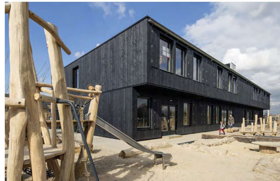
De tijdelijke school Nieuw Amsterdam (SeArch) bestaat uit CLT-modules die over vijf jaar worden gedemonteerd op een nieuwe locatie opnieuw worden opgebouwd.
