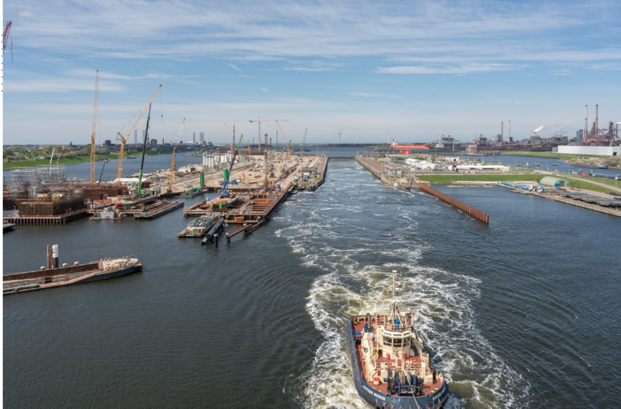
IJmuiden, aanleg nieuwe zeesluis.
